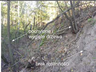
Fot.1 Zbocze osuwiska w Głębocko
