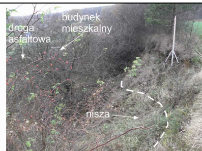
Fot. 18 Zbocze osuwiska w Jankowie Młyn z niszami zsuwowymi
