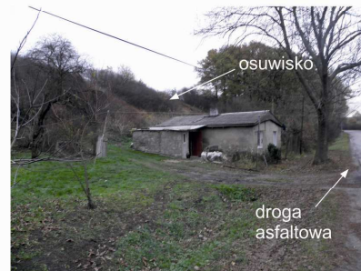
Fot. 20 Budynek mieszkalny u podnóża osuwiska w Jankowie Młyn
