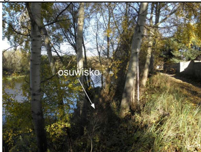
Fot.25 Zabudowania w koronie osuwiska w Czapurach
