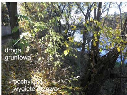
Fot.27 Stoki osuwiska w Czapurach
