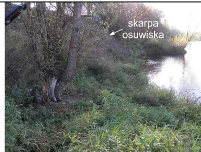
Fot.26 Skarpa przykorytowa w Czapurach nad rzeką Wartą
