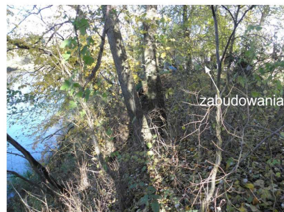
Fot.28 Budynek gospodarczy na zboczu osuwiska w Czapurach
