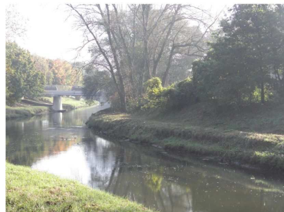
Fot.44 Skarpa przykorytowa w Mosinie (Os11)
