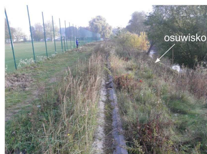
Fot.48 Korona osuwiska w Mosinie (Os12) z rynną betonową do odprowadzenia wód opadowych
