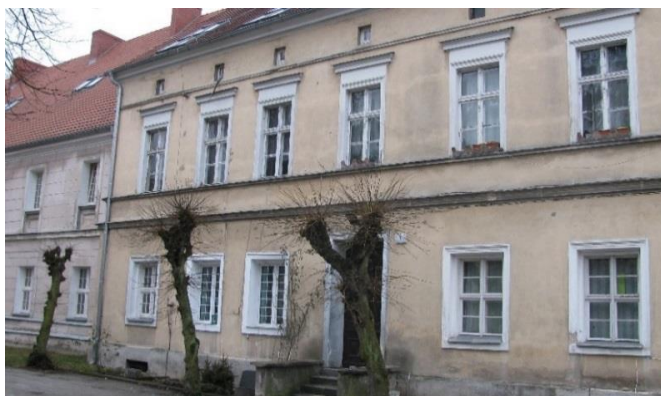
Stan przed remontem, fot. Archiwum
