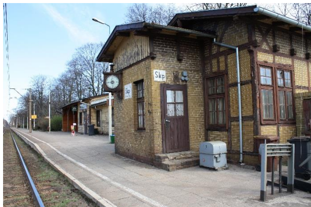
Stan przed remontem, fot. Archiwum
