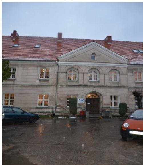
Stan przed remontem, fot. Archiwum
