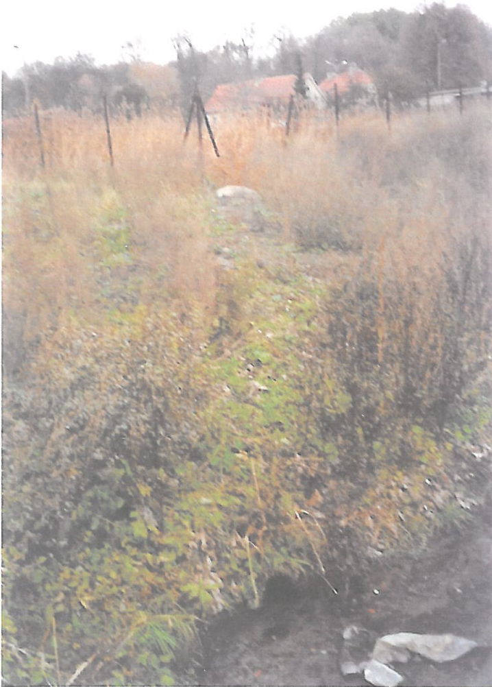
7. Wylot rurociągu zrzutowego \varnothing 20 cm ze stawu na dz. 228/2 do rowu G w hm 3+06
