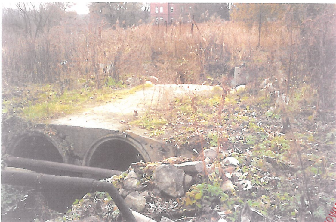
2. Rów G- wlot do przepustu 2 Ø 100 cm w hm 3+89
