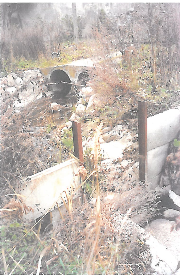
5. Widok na zastawkę w hm 3+75 rowu G i przepust 2 Ø 100 w hm 3+87
