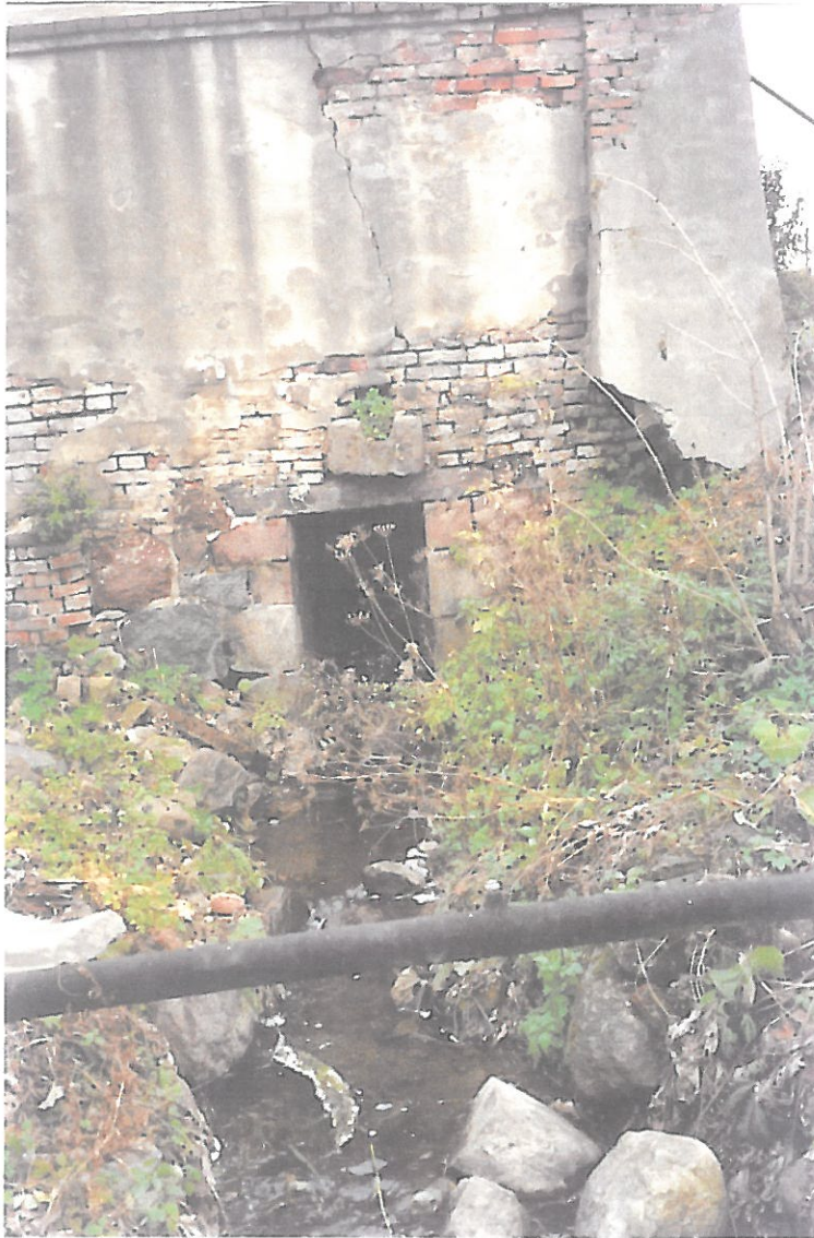
1. Rów G- wylot z przepustu pod ul. Poznańską
