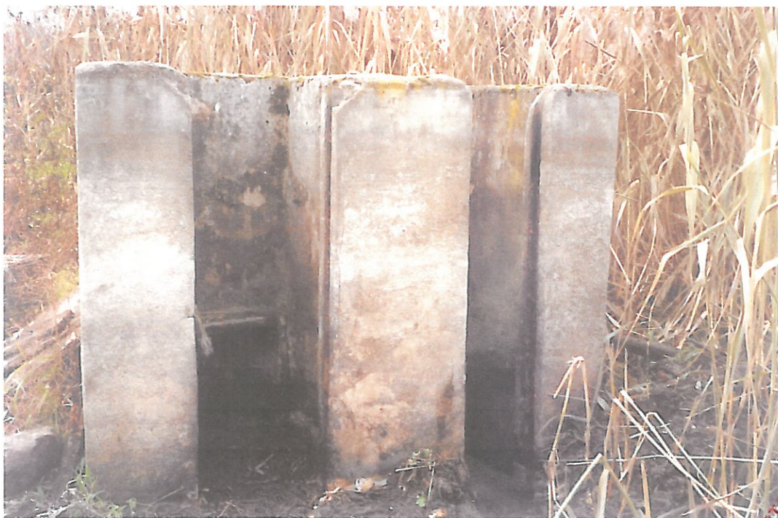
12. Stojak istniejącego mnicha na wylocie ze stawu, na dz. 228/2
