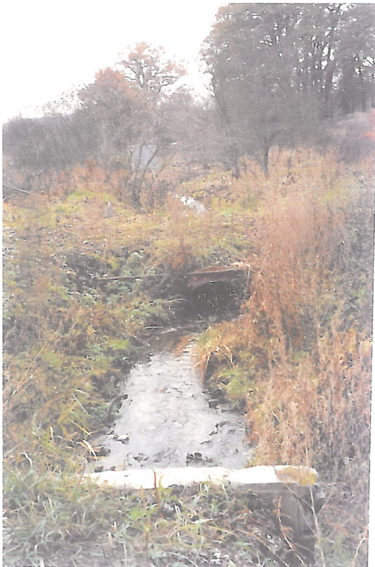
9. Rów G- widok od WG na wlot do przepustu Ø 80 cm w hm 2+84
