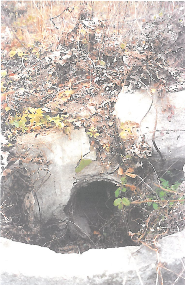
4. Istniejący wlot do ujęcia wody na staw, na dz. 228/2
