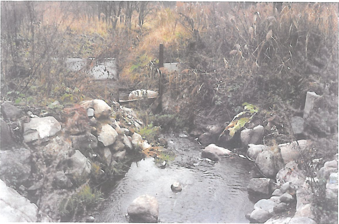
3. Rów G- widok na istniejącą zastawkę w hm 3+75 od WG
