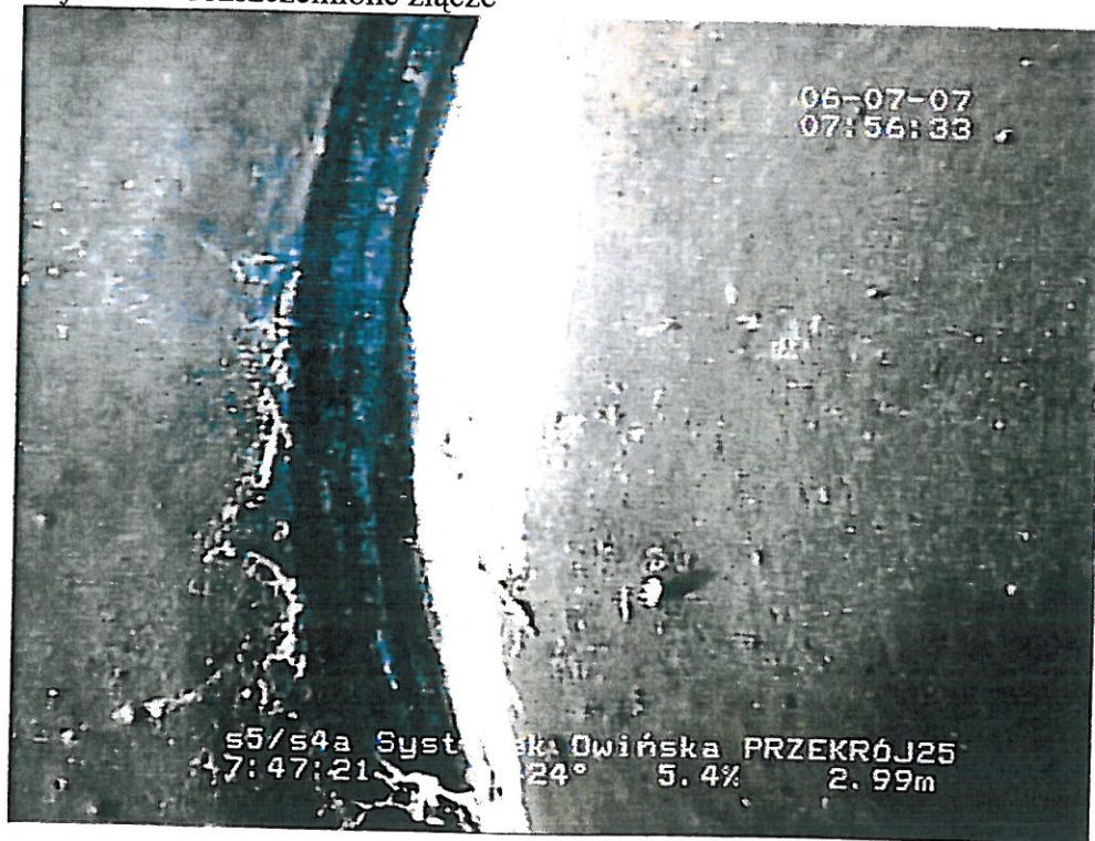
Zdj nr 14 – rozszczelnione złącze
