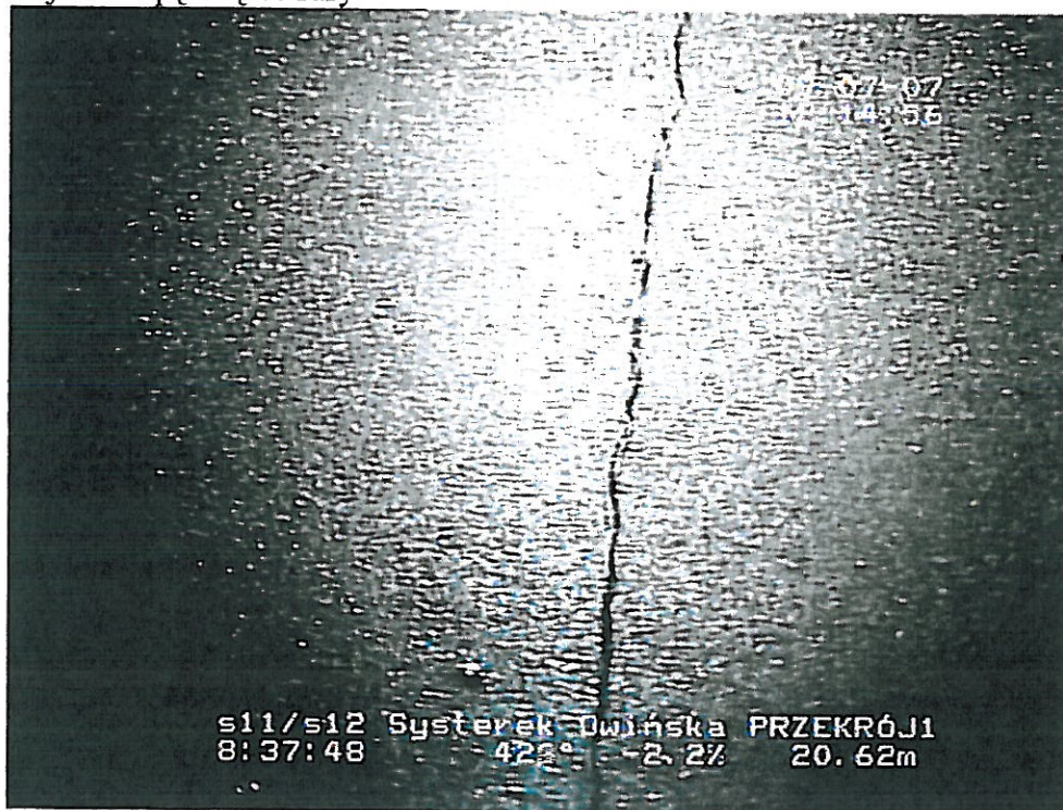
Zdj nr 8 – pęknięcie rury
