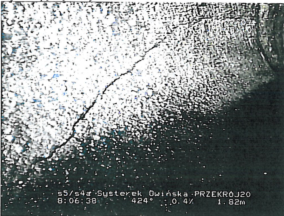
Zdj nr 6 – pęknięcie rury
