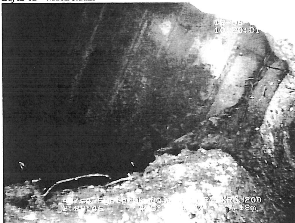
Zdj nr 12 - widok studni
