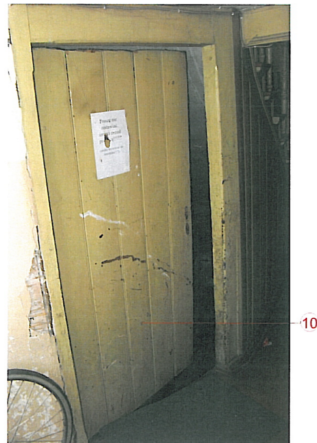
Drzwi wejściowe do piwnicy
