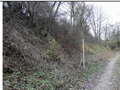
Fot. 14 Droga gruntowa u podnóża osuwiska w Górze (Os4)
