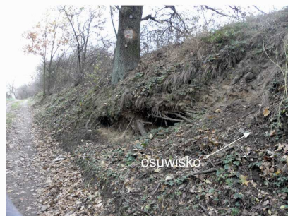
Fot. 16 Zbocze osuwiska w Górze (Os4) drzewo podkopane przez zwierzęta
