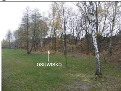
Fot.21 Budynek w koronie osuwiska w Gortatowie
