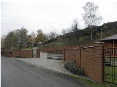
Fot.23 Stoki osuwiska w Gortatowie wzmocnione murem oporowym
