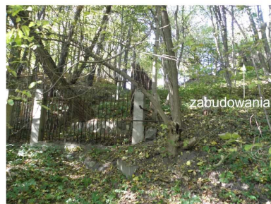
Fot.32 Ogrodzenia posesji na zboczu osuwiska w Starym Puszczykowie
