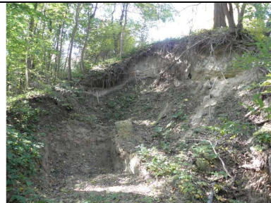
Fot.30 Podcięcie skarpy w Starym Puszczykowie w okolicy klasztoru
