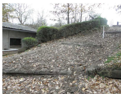
Fot.62 Prowizoryczne zabezpieczenia przed osuwaniem gruntu w Kaczynie
