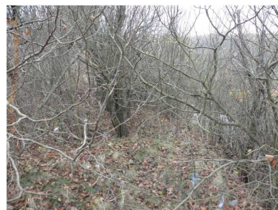
Fot.66 Korona stoków osuwiska w Radzewicach
