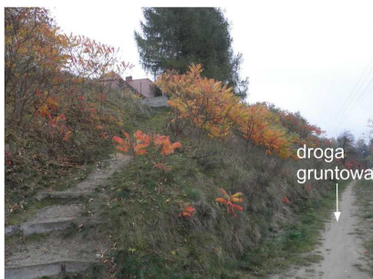
Fot.65 Nowa zabudowa w koronie skarpy osuwiska w Radzewicach
