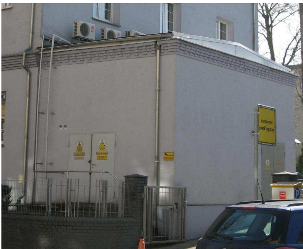
Zdjęcie 17 - Trafostacja , elewacja od strony ul. Jackowskiego
