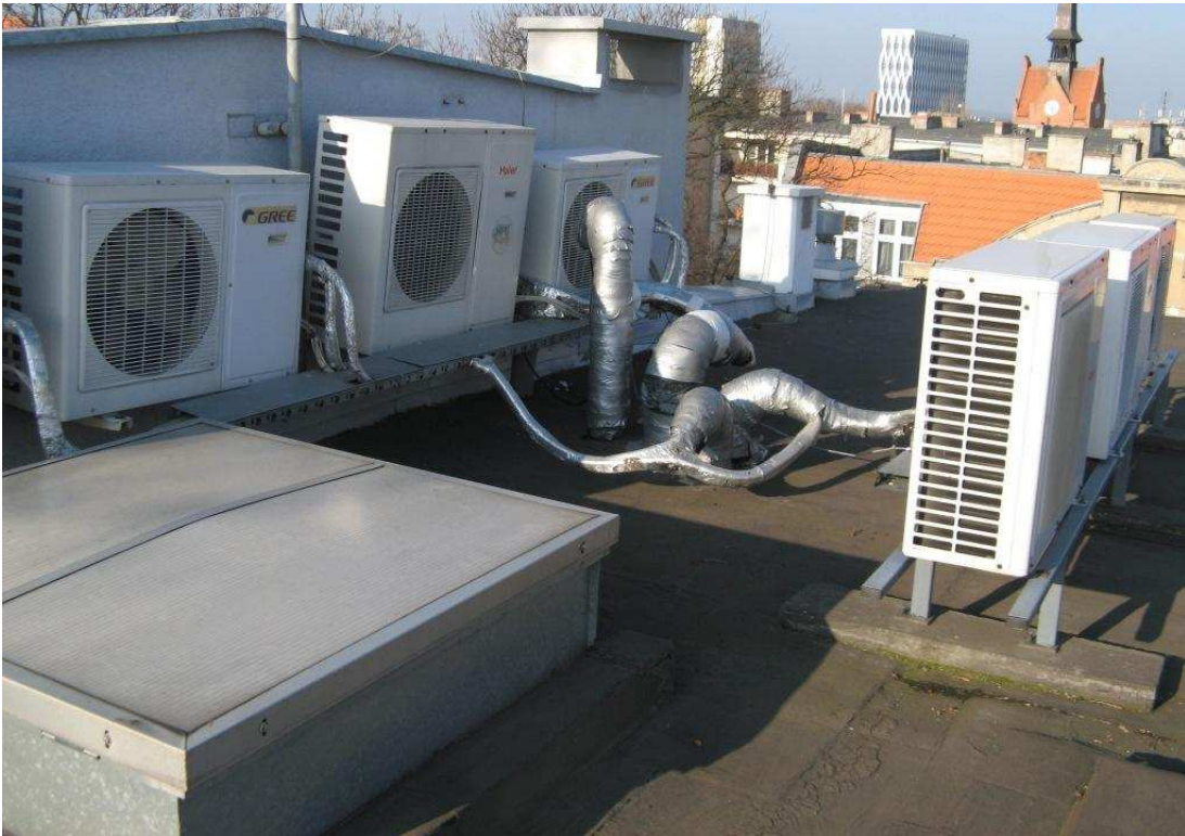
Zdjęcie 9 - Widok na dach na segmencie „D” : klimakonwektory przy wschodnim szczycie świetlika
