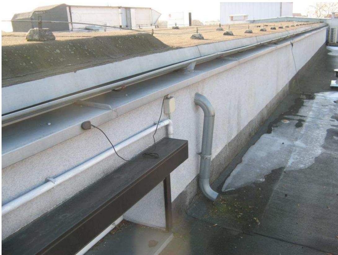
Zdjęcie 6 - Dach na świetliku nad segm. "C" – dwuspadowy - widok od strony ul. Jackowskiego (strona północna):
