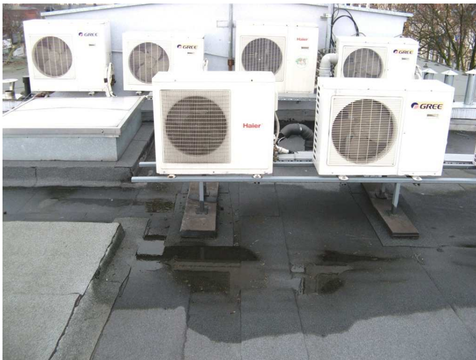
Zdjęcie 8 - Widok na dach na segmencie „D” : klimakonwektory przy wschodnim szczycie świetlika
