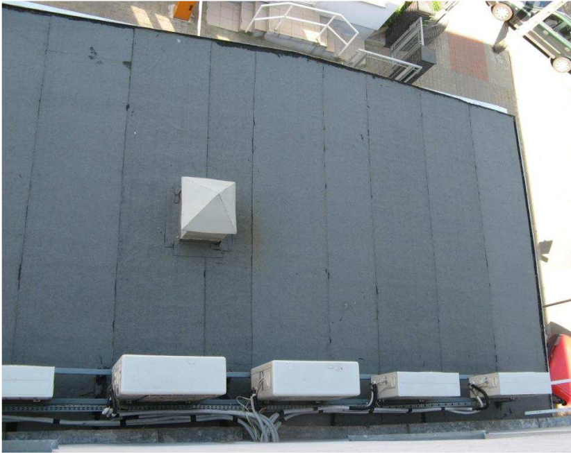
Zdjęcie 15 - Trafostacja , widok dachu
