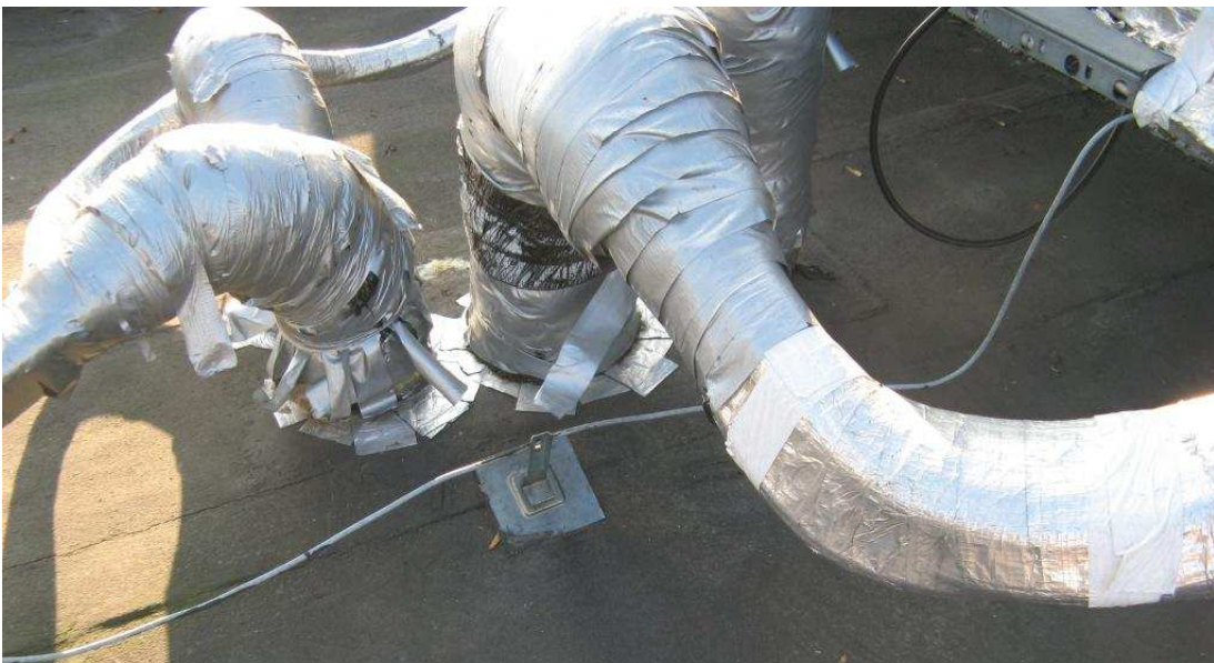
Zdjęcie 10 - Szczegół ze Zdjęcia 9 : widać grube wiązki przewodów i kabli instalacji klimatyzacyjnej przechodzące przez stropodach. Widać folię aluminiową niszczoną przez ptaki.
