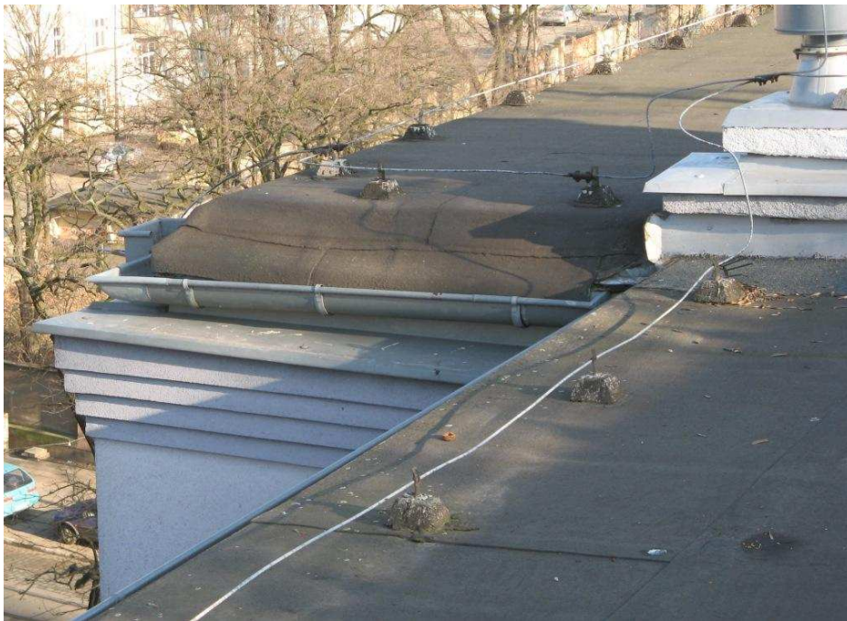
Zdjęcie 7 - Widok na dachy segment „C” ( dołem ) i „D” (góra zdjęcia) od strony ul. Jackowskiego :
