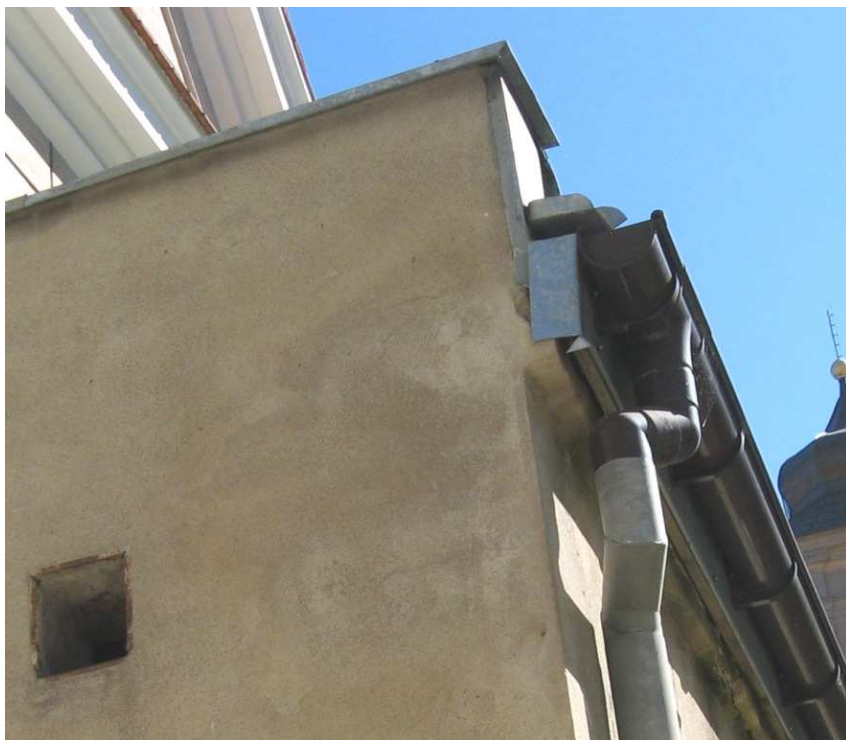
foto 2 : widać mały gzyms, deskę między gzymsem a blachą, obróbkę z blachy
