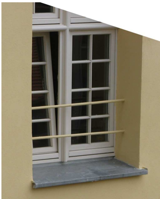
foto 1: przykład jak należy usytuować pręty w oknach
