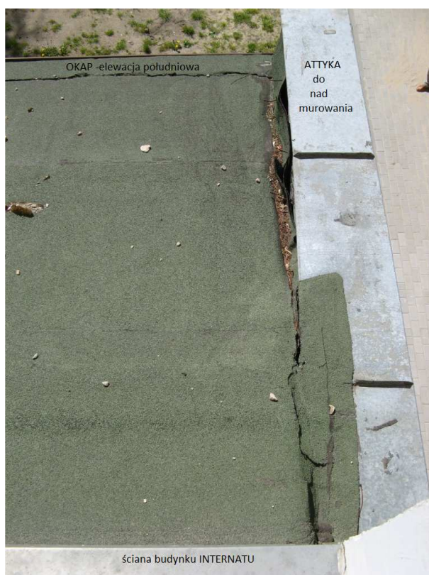
foto 1 : widok na dach Łącznika przy ścianie Internatu
