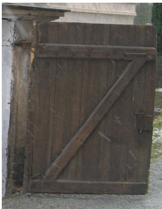
foto 4 : drzwi do zejścia do kotłowni gazowej
