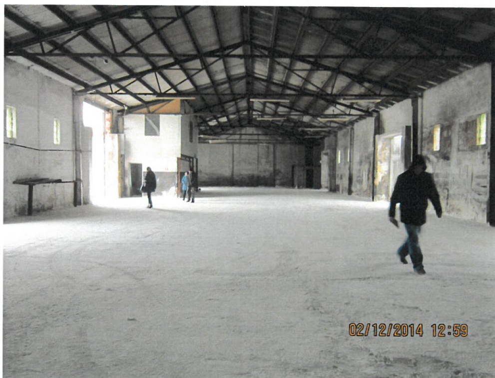
Budynek magazynu po usunięciu odpadów
