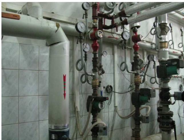
3. Siłowniki na instalacji rozdzielczy podlegające wymianie
