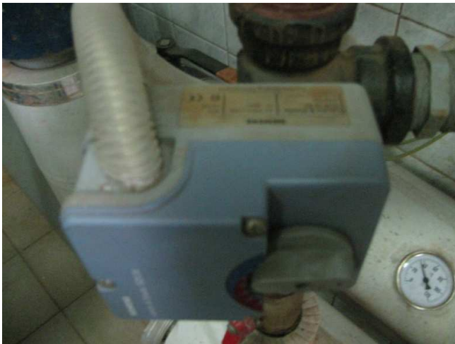
3. Siłowniki na instalacji rozdzielczy podlegające wymianie
