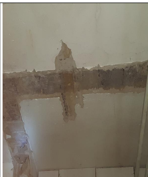
Fot.14 Strop DZ-3 w części dobudowanej
