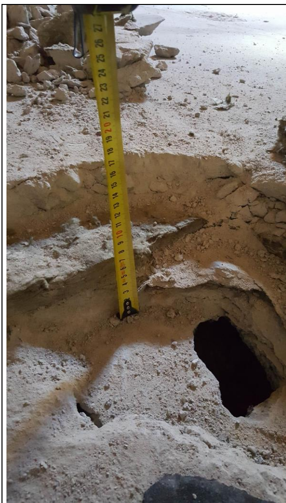
Fot.15 Odkrywka stropu na piętrze
