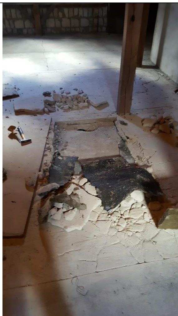
Fot.16 Odkrywka stropu na piętrze
