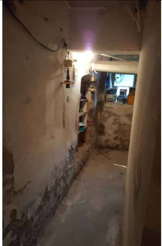
Fot.10 Uszkodzenie tynku kondygnacji piwnicy
