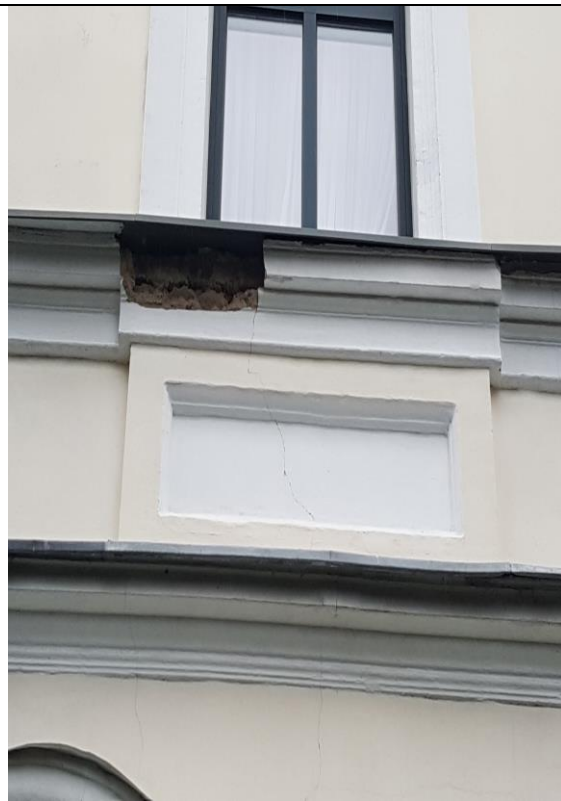
Fot.1 Ubytki w elewacji
