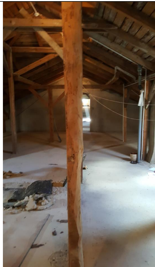
Fot.23 Słup nadający się do wymiany
