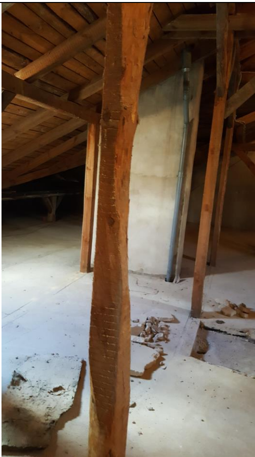
Fot.22 Słup nadający się do wymiany
