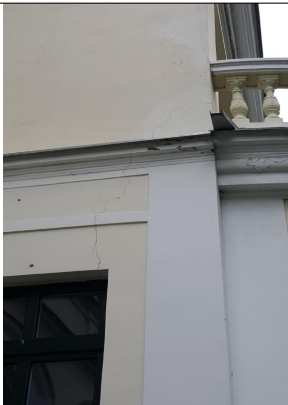
Fot.3 Pęknięcie w elewacji
