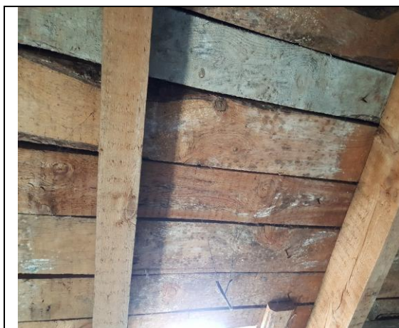
Fot.24 Wykwity na deskowaniu
