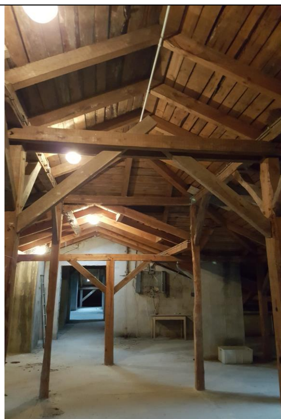
Fot. 18 Widok więźby dachowej
