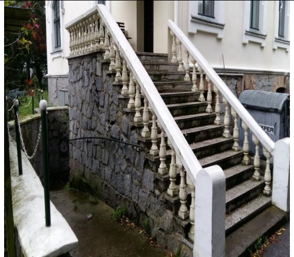
Fot.6 Zaniedbany mur kamienny
