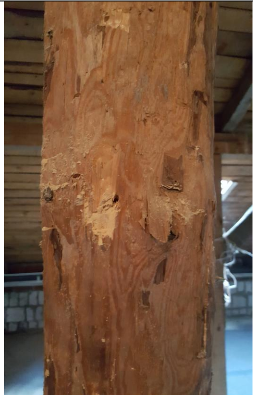
Fot.21 Korozja słupa wywołana szkodnikami
