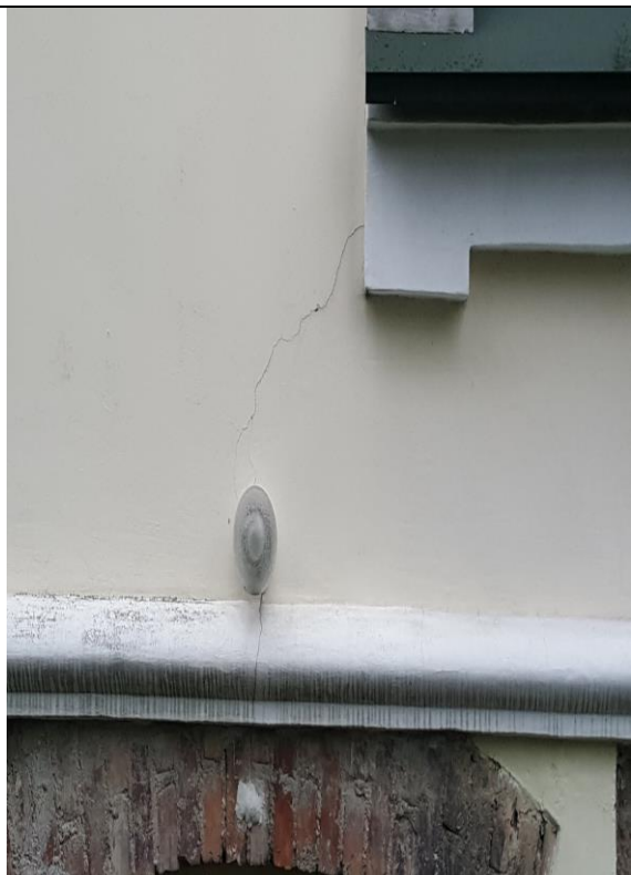
Fot.4 Pęknięcie w elewacji
