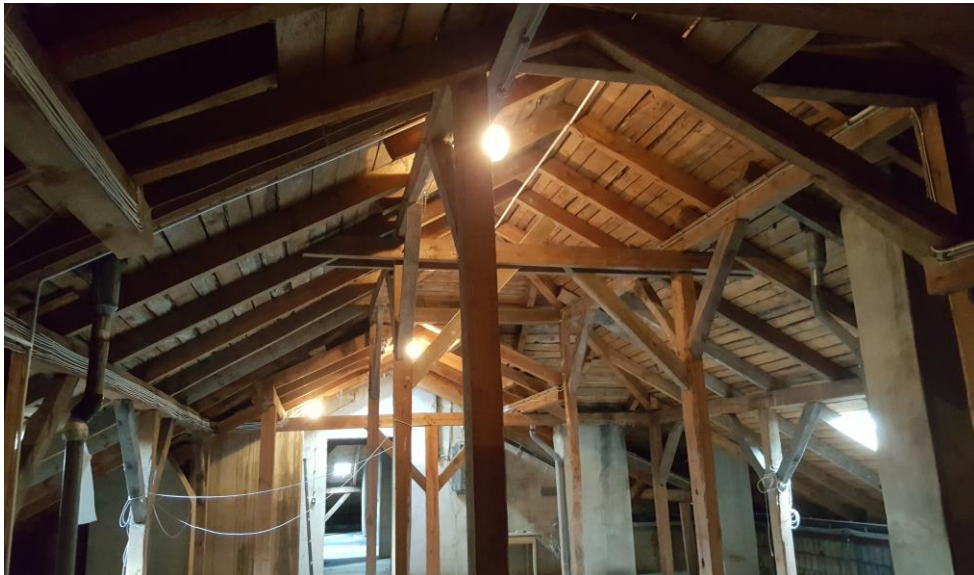
Fot.19 Widok więźby dachowej
