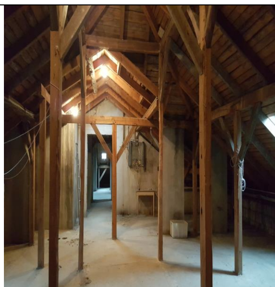
Fot. 17 Widok więźby dachowej
