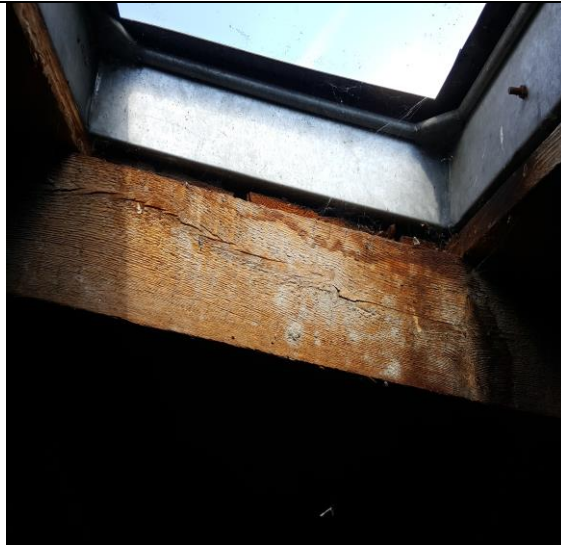
Fot.20 Zawilgocona krokiew pod oknem dachowym
