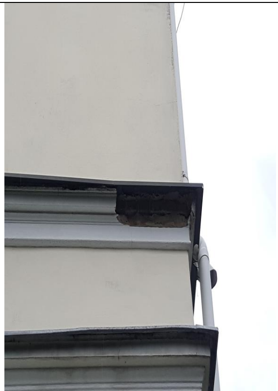
Fot.2 Ubytki w elewacji
