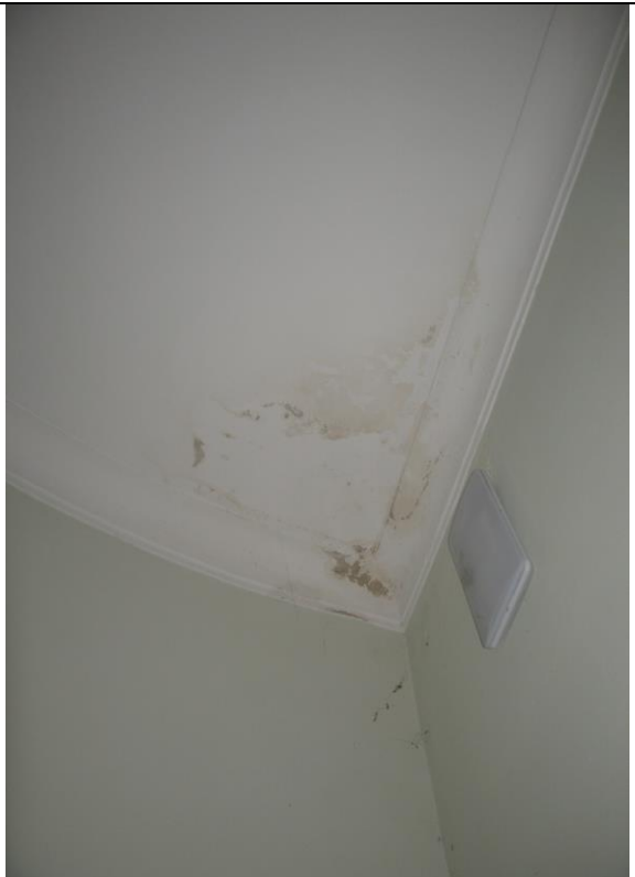
Fot.8 Wilgoć na suficie przedsionka (pom. 0.01 wg K02)
