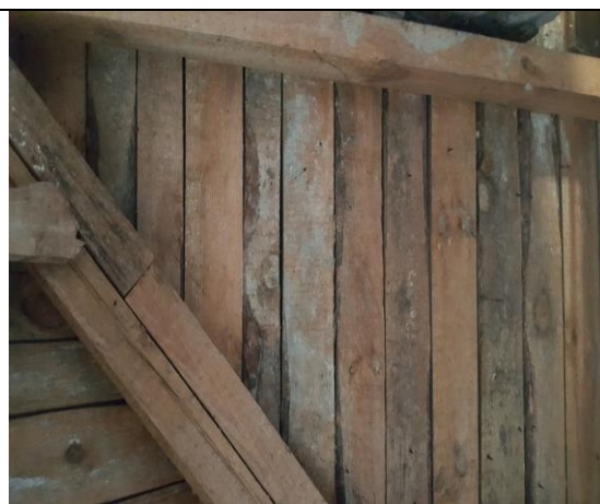
Fot.25 Wykwity na deskowaniu
