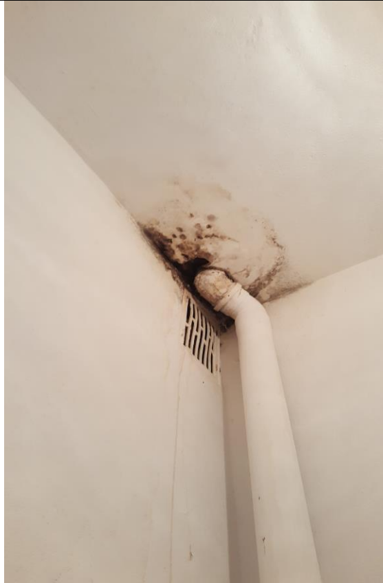
Fot.9 Zawilgocenie i zagrzybienie sufitu w pom. 1.02 (rys. K03)
