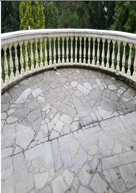
Fot.7 Widok tarasu nad przedsionkiem (pom. 0.01)
