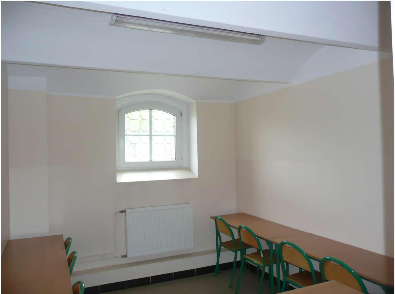
Fot. 6. Pomieszczenie w piwnicy.
