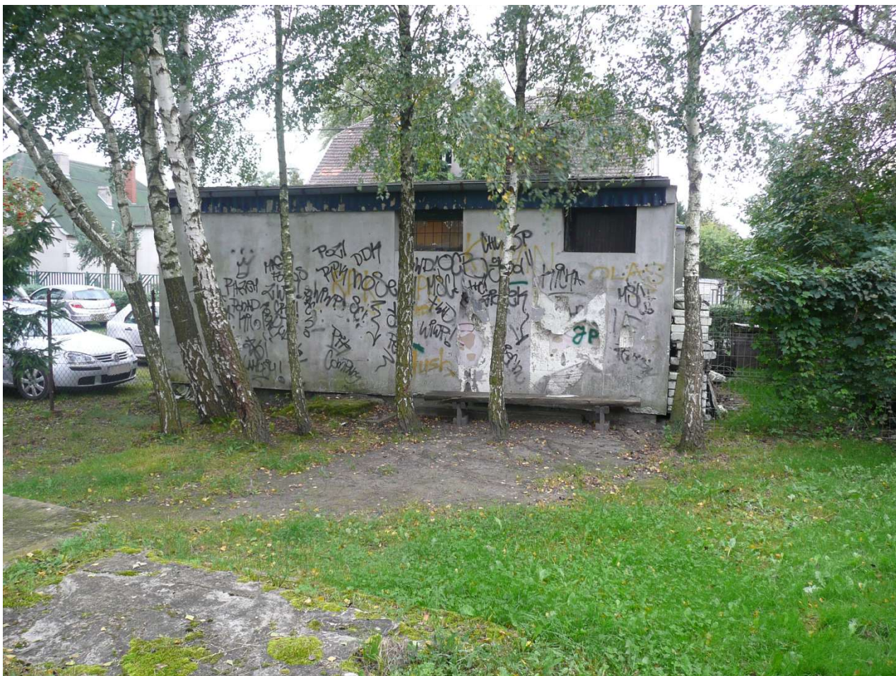
Fot. 3. Budynek do rozbiórki.
