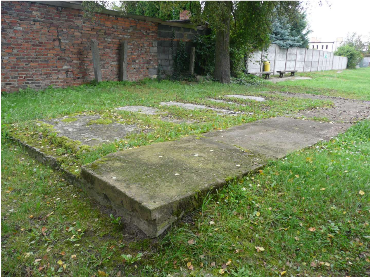
Fot. 21. Zbiornik żelbetowy do rozbiórki.
