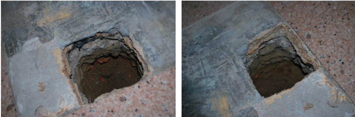
Fot 3-4. Odkrywka posadzki nr 1 w pomieszczeniu budynku dydaktycznego.
