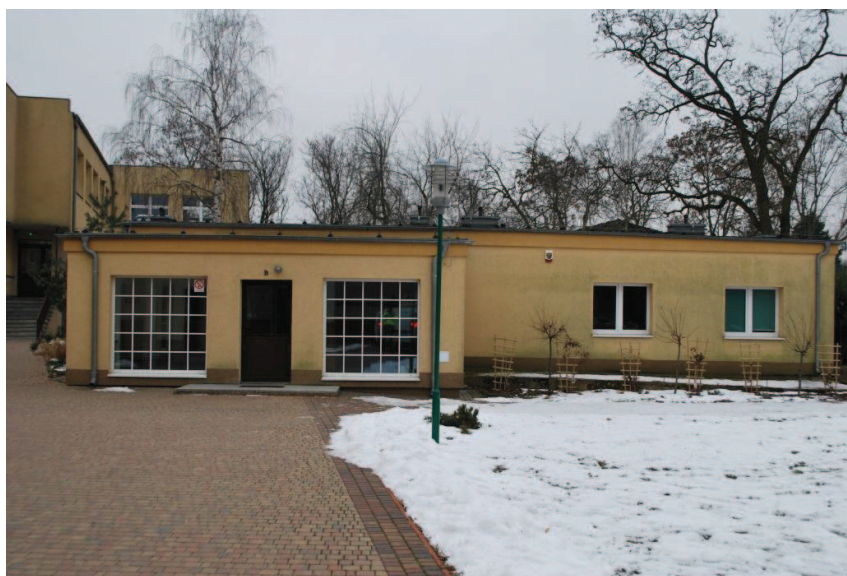
Fot 2. Ogólny widok budynku od strony północnej
