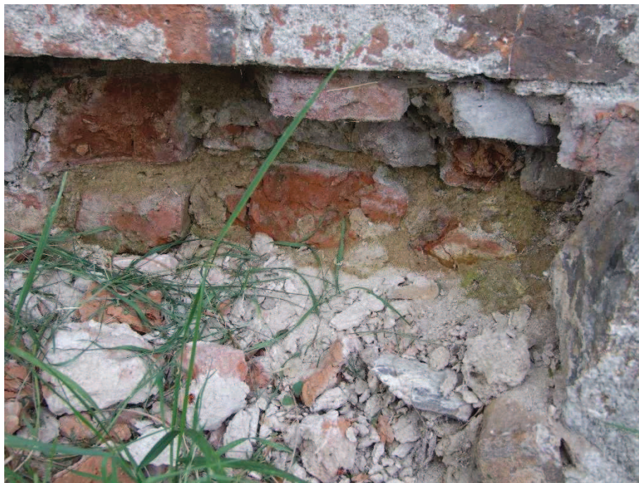
Fot. 17. Mur B - widoczne odspojenie kamiennej okładziny cokołu.
