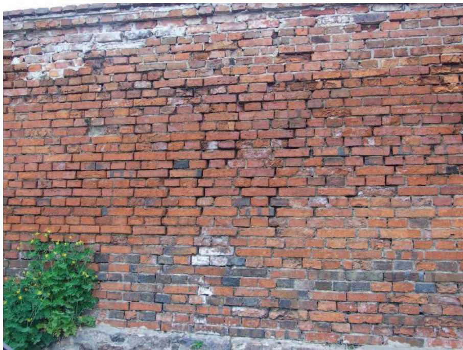
Fot. 15. Mur B - widoczne pionowe zarysowania oraz wtórne przemurowanie górnej krawędzi muru.
