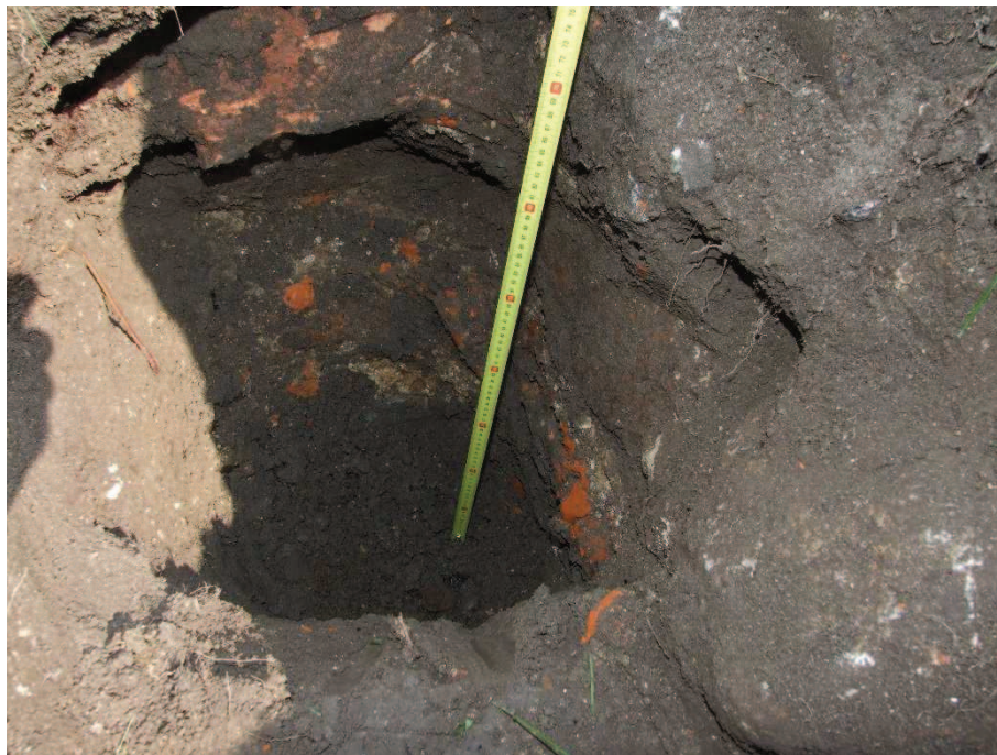
Fot. 8. Mur A - odkrywka ławy fundamentowej.
