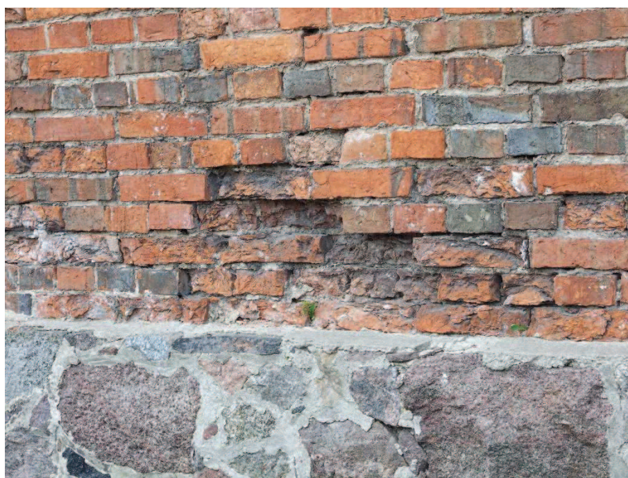
Fot. 14. Mur B - widoczny ubytek cegieł wymagający przemurowania.
