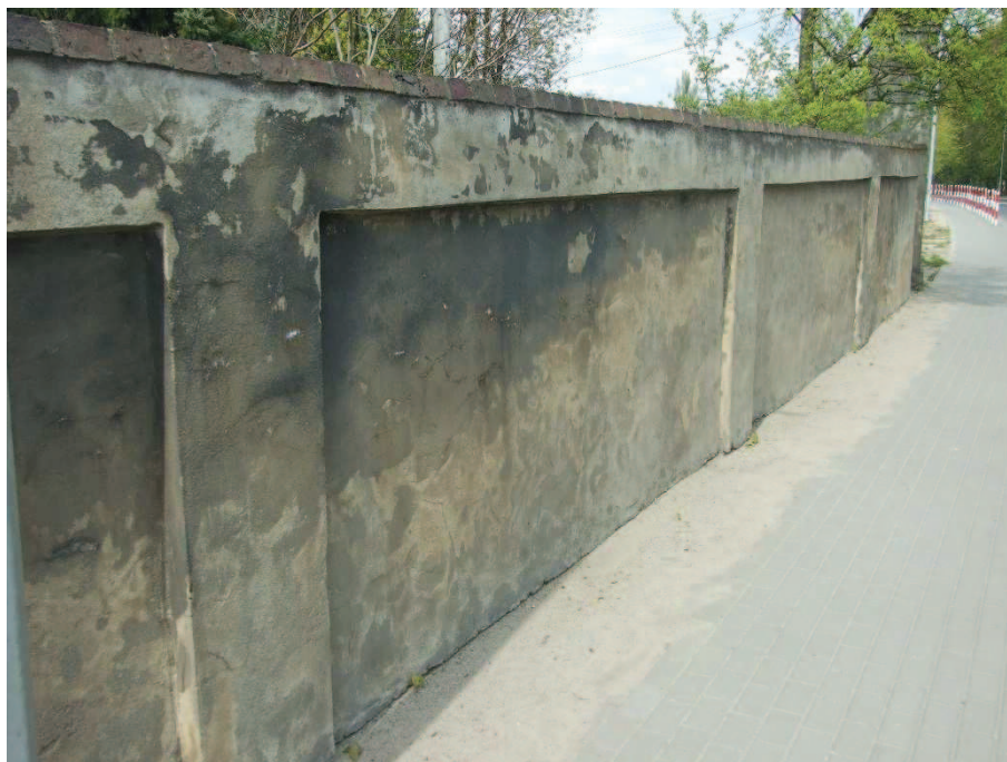
Fot. 1. Mur A - widok od strony ul. Poznańskiej - widoczne ślady zawilgocenia.
