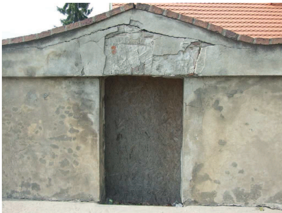
Fot. 2. Mur A - otwór w środkowej części muru - widoczne zarysowania w obrębie nadproża, widok od strony ul. Poznańskiej.
