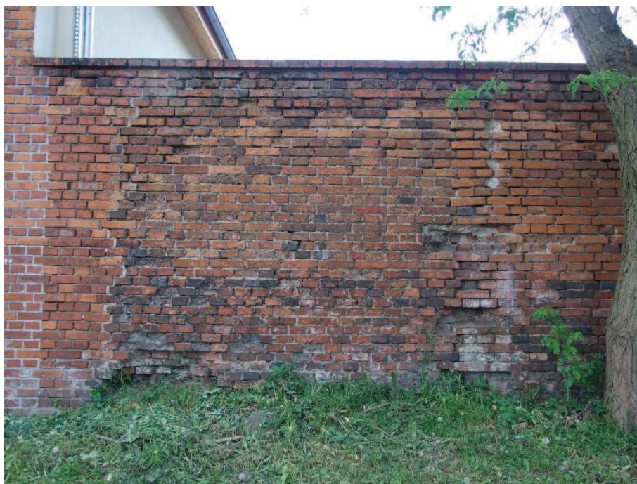
Fot. 18. Mur B - wtórne zamurowanie, widoczny brak właściwego przewiązania cegieł.
