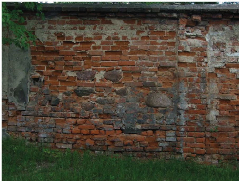
Fot. 5. Mur A - widoczne uszkodzenia cegieł, widok od strony parku.
