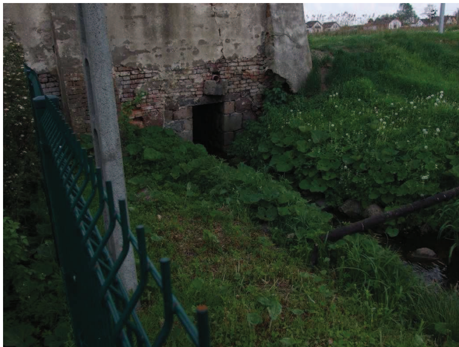
Fot. 9. Mur A - południowy koniec muru nad przepustem, widoczne pionowe zarysowanie i skrajna przypora muru pozbawiona fundamentu.
