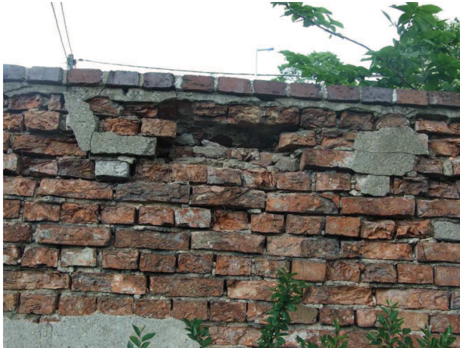
Fot. 7. Mur A - ubytek w murze wymagający przemurowania.
