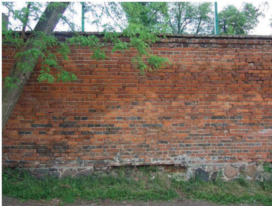
Fot. 11. Mur B - widoczne odspojenie kamiennej okładziny cokołu i ubytki spoin, widok od strony ul. Cysterek.
