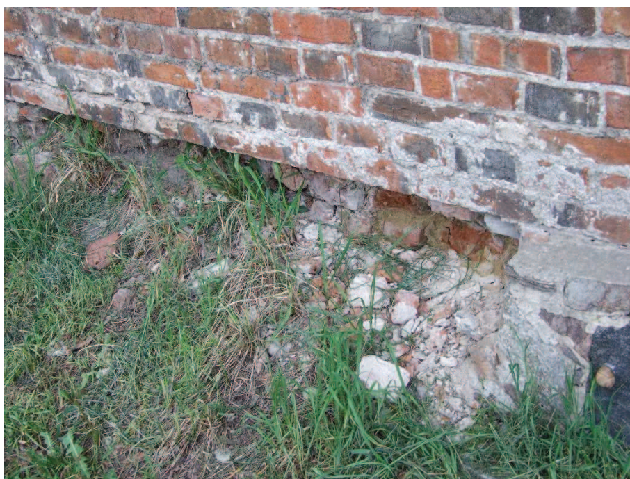
Fot. 16. Mur B - widoczne odspojenie kamiennej okładziny cokołu.
