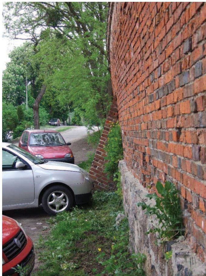
Fot. 13. Mur B - widoczne odchylenie od pionu.
