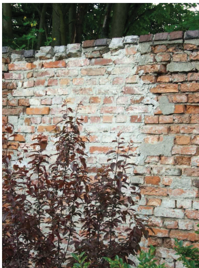
Fot. 10. Mur A - wtórne zamurowanie, widoczny brak poprawnego przewiązania muru.
