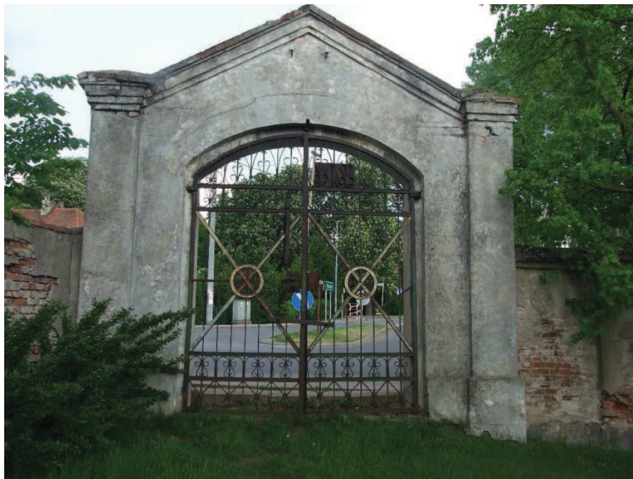
Fot. 3. Mur A - brama portalowa - widoczne zarysowanie w górnej części portalu, widok od strony parku.
