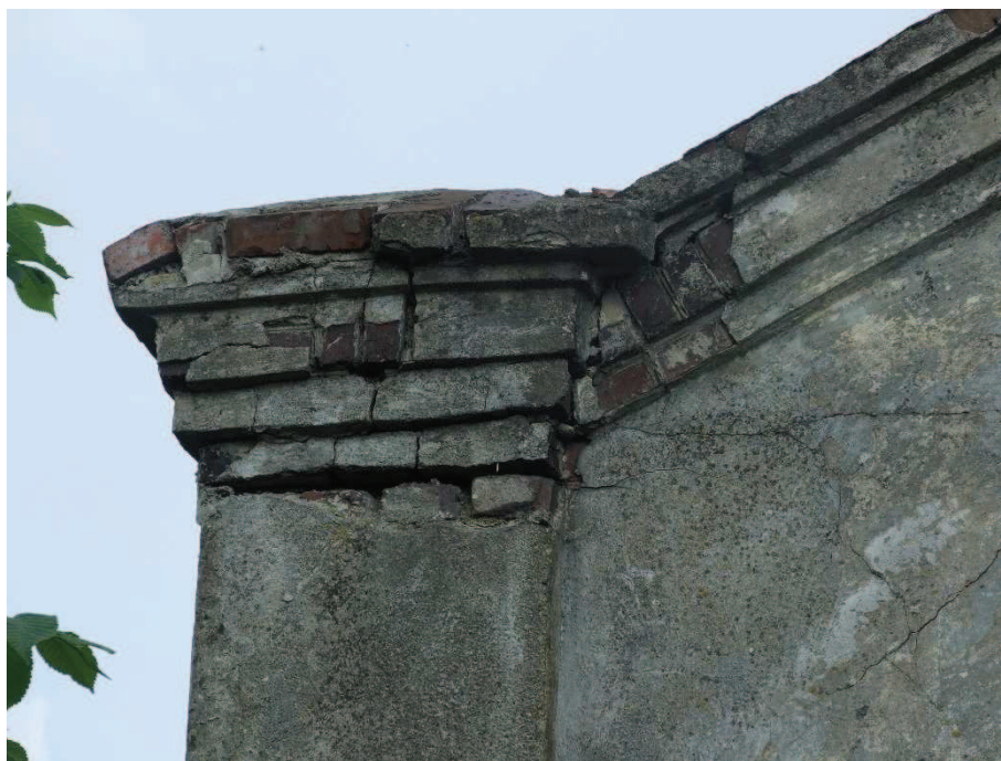
Fot. 4. Mur A - brama portalowa - widoczne zarysowanie w górnej części portalu.
