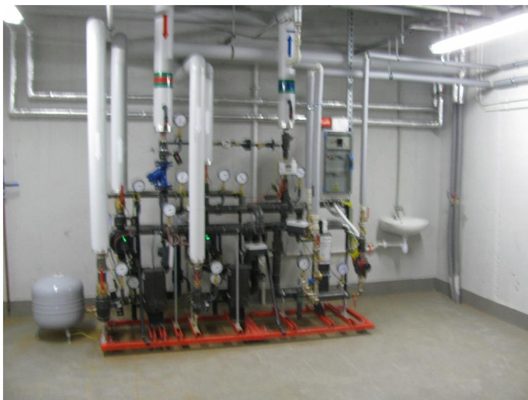
Sterowanie wentylacji w węźle cieplnym
