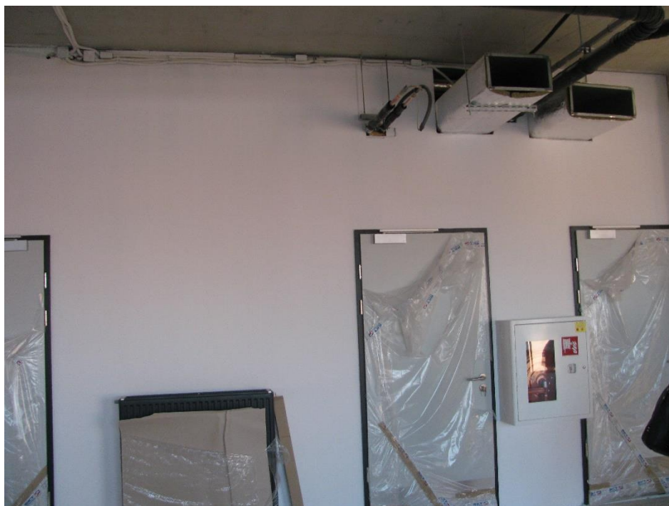
Sanitariaty parteru, I i II piętra
