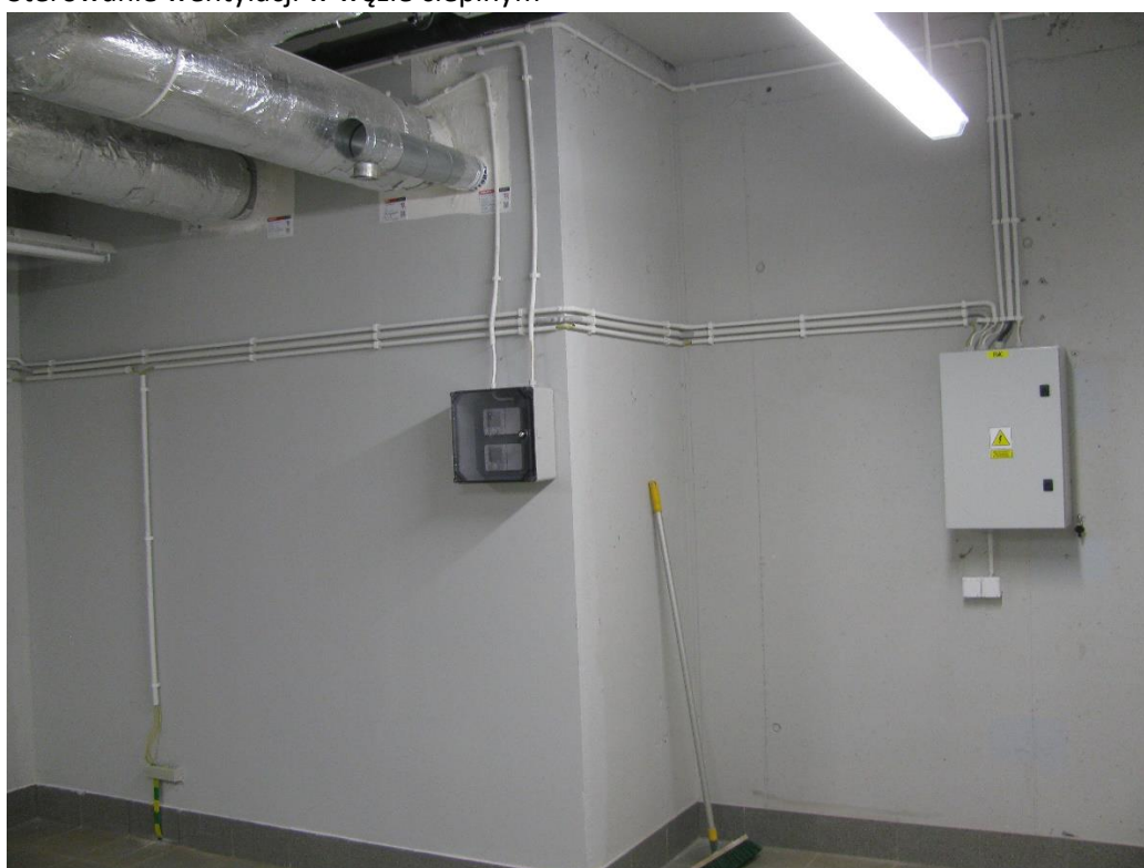
Sterowanie wentylacji w węźle cieplnym
