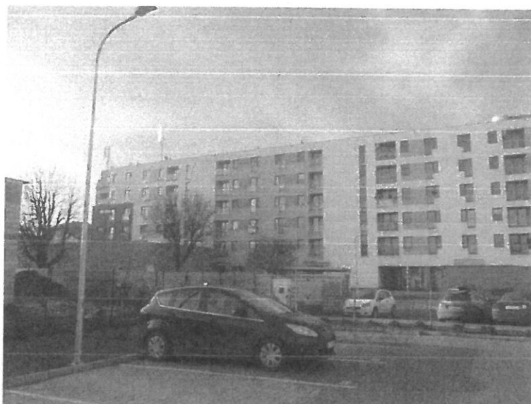
Zał. nr 1: Widok ogólny instalacji radiokomunikacyjnej.
