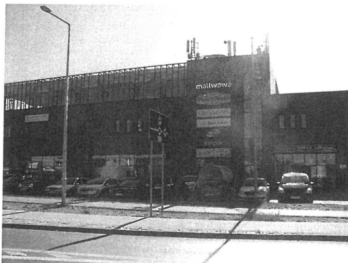
Zał. nr 1: Widok ogólny instalacji radiokomunikacyjnej.
