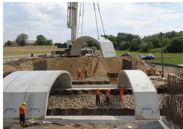
Budowa mostu w Nadrożnie
