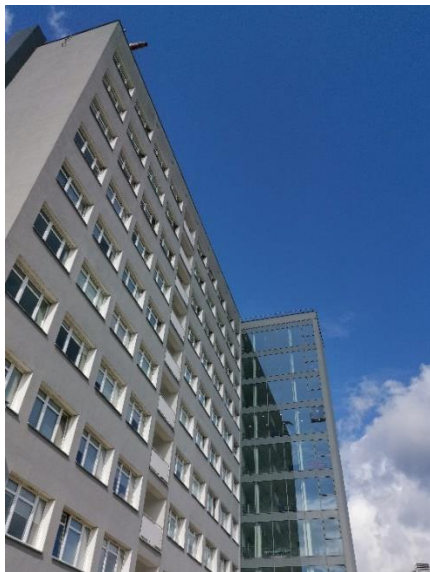
Nowy szyb windowy
