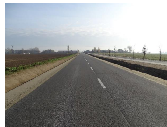
Budowa ścieżki rowerowej na drodze Gądkki – Szczodrzykowo
