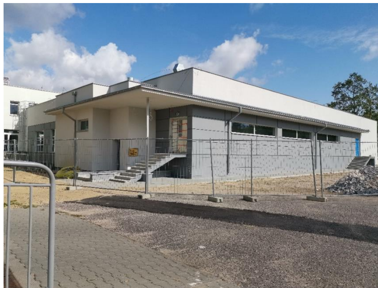
Budowa bloku operacyjnego
