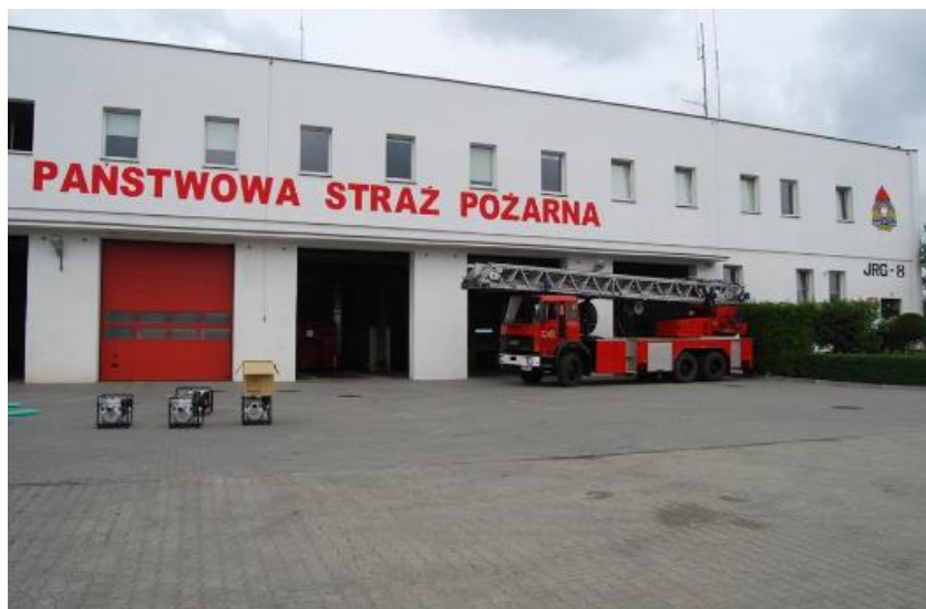
Kontynuacja modernizacji Jednostki Ratowniczo-Gaśniczej nr 8 w Bolechowie
