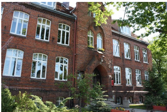
Przed rewitalizacją elewacji
