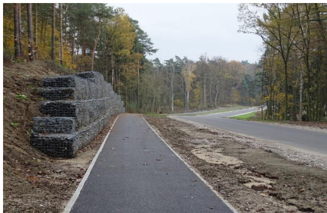
Budowa ścieżki rowerowej na drodze Pobiedziska – Iwno (na odcinku od Pobiedzisk do Kociałkowej Górki)
