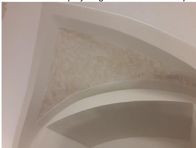
Zabezpieczone pierwotne warstwy tynkarskie lunet, w dużym refektarzu, z widocznymi rytami dekoracji ornamentальной
