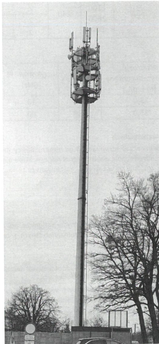
Zdjęcie 1 Badany obiekt
