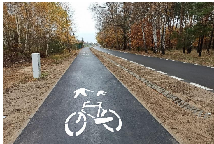
Budowa ścieżki rowerowej na drodze Szreniawa – Komorniki (f. Zarząd Dróg Powiatowych w Poznaniu)
