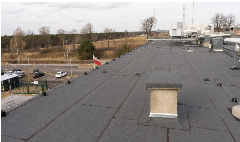
Remont pokrycia dachu budynku Zespołu Szkół im. Gen. Dezyderego Chłapowskiego w Bolechowie (f. Starostwo Powiatowe w Poznaniu, Wydział Inwestycji i Remontów)
