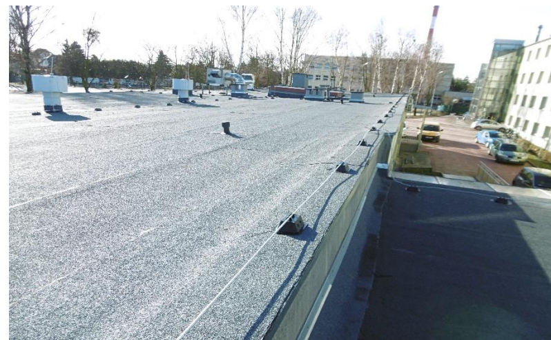
Naprawa pokrycia dachu internatu wraz z kuchnią i łącznikiem Zespołu Szkół im. Adama Wodźniczki w Mosinie (f. Starostwo Powiatowe w Poznaniu, Wydział Inwestycji i Remontów)
