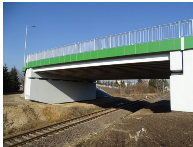
Nowy wiadukt w Murowanej Goślinie (f. Zarząd Dróg Powiatowych w Poznaniu)
