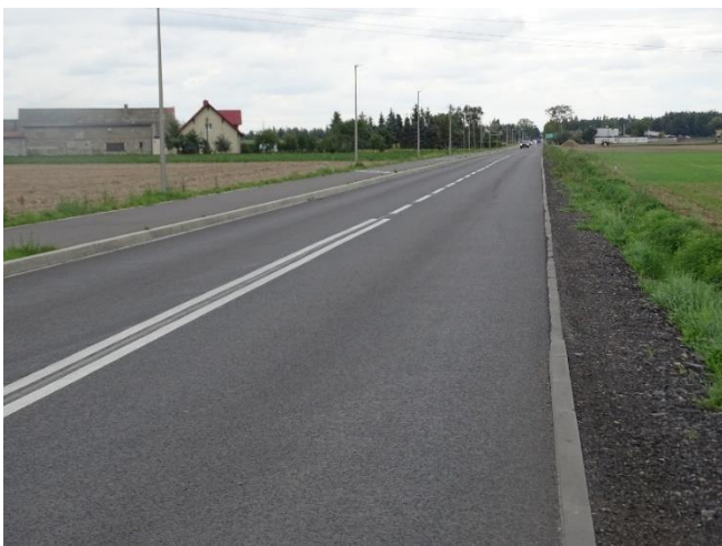
Przebudowa drogi Buk – Szewce (f. Zarząd Dróg Powiatowych w Poznaniu)
