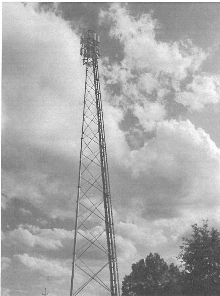
Zał. nr 1: Widok ogólny instalacji radiokomunikacyjnej.
