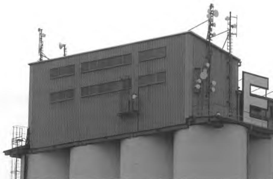
Widok instalacji radiokomunikacyjnej Stacja Netia KORNT001 - KORNM00001 Gądki, ul. Zbożowa 1.
