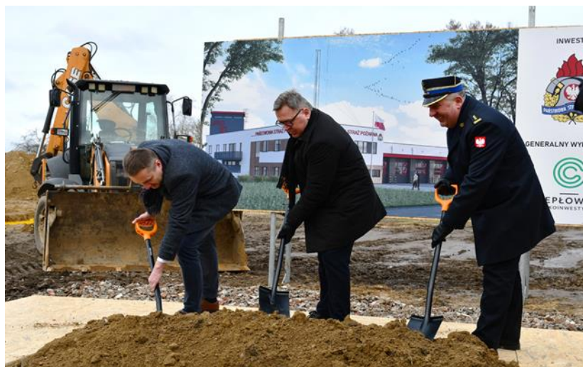
Uroczyste rozpoczęcie prac budowlanych Jednostki Ratowniczo-Gaśniczej nr 10 w Iwnie (f. www.powiat.poznan.pl )
