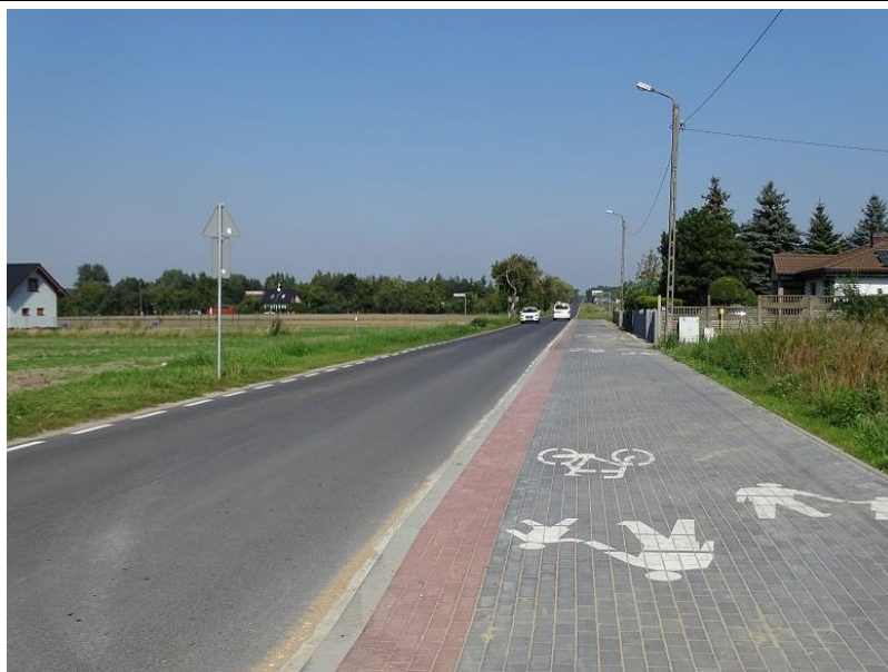
Ścieżka rowerowa Sapowice – Strykowo (fot. Zarząd Dróg Powiatowych w Poznaniu)
