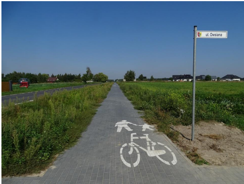
Ścieżka rowerowa Sapowice – Strykowo (f. Zarząd Dróg Powiatowych w Poznaniu)
