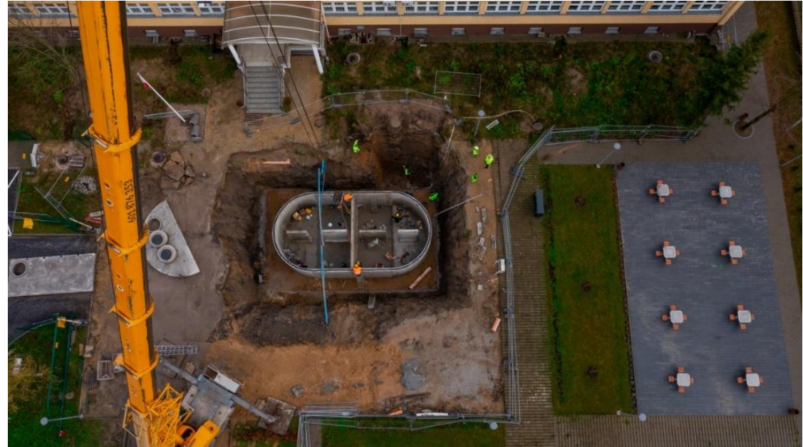
Budowa podziemnego zbiornika retencyjnego dla wód opadowych na terenie Zespołu Szkół im. Gen. Dezyderygo Czapowskiego w Bolechowie (f. Wydział Inwestycji i Remontów)
