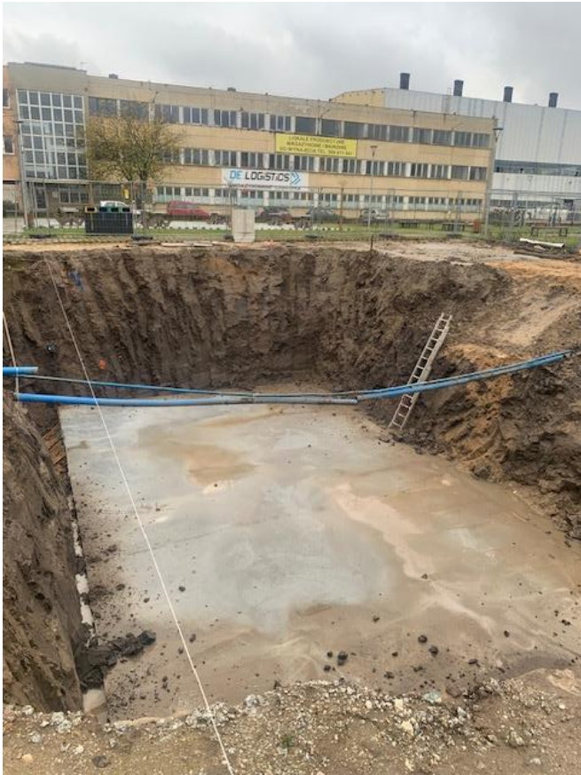
Budowa podziemnego zbiornika retencyjnego dla wód opadowych na terenie Zespołu Szkół im. Gen. Dezyderygo Czapowskiego w Bolechowie (f. Wydział Inwestycji i Remontów)
