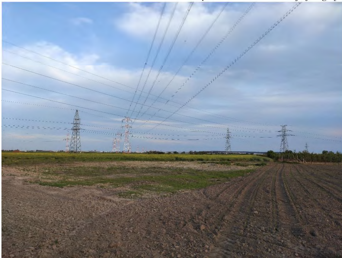
Zdjęcie nr 1. 2×LNN 400 kV Plewiska - Kromolice – widok fragmentu (słup nr 3).
