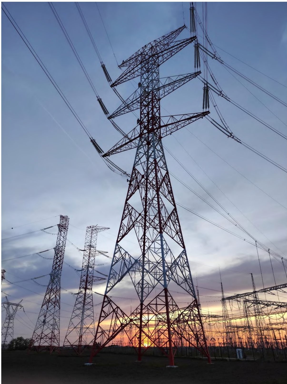
Zdjęcie nr 3. 2×LNN 400 kV Plewiska - Kromolice – widok fragmentu (słup nr 2).
