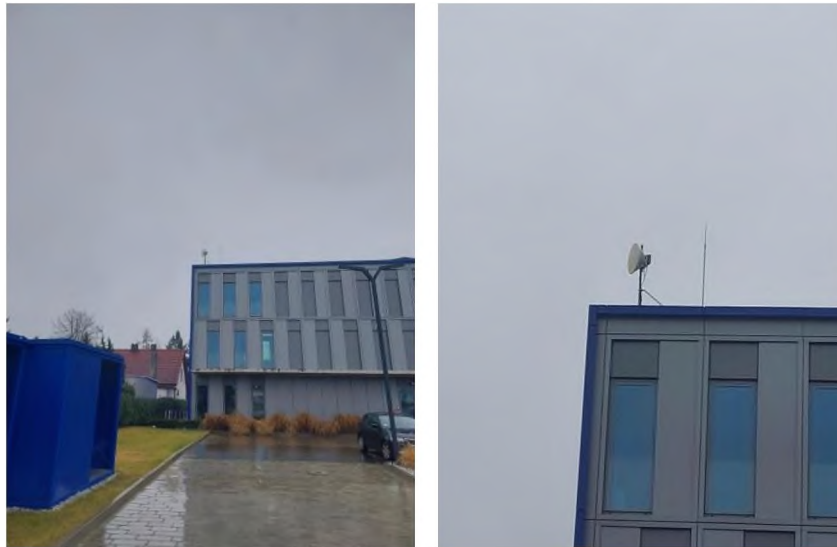
Widok obiektu wraz z zainstalowanym zespołem antenowym
