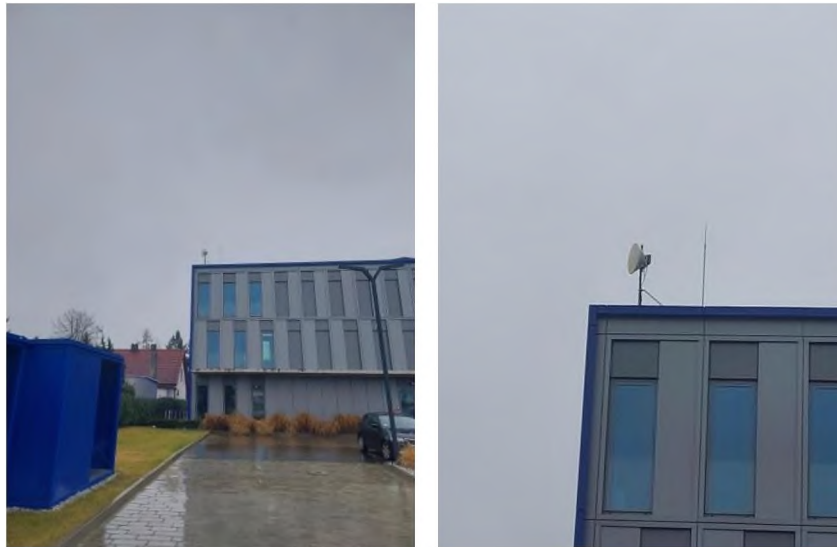
Widok obiektu wraz z zainstalowanym zespołem antenowym
