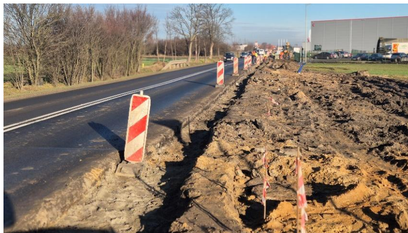
Budowa ścieżki rowerowej na drodze Komorniki – Plewiska (fot. Zarząd Dróg Powiatowych w Poznaniu)
