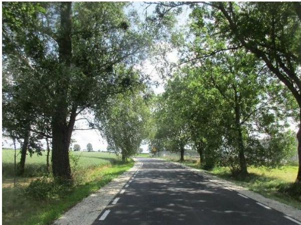
Wyremontowana droga Bnin – Konarskie (fot. Zarząd Dróg Powiatowych w Poznaniu)
