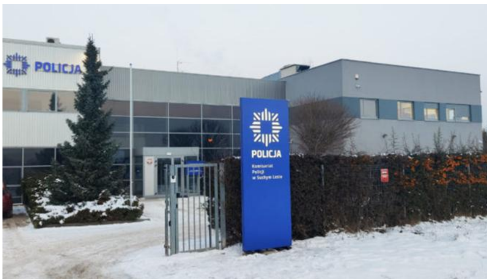
Dofinansowanie przebudowy budynku biurowo-magazynowego na potrzeby Komisariatu kwotą 1.000.000 zł (fot. Komenda Miejska Policji w Poznaniu)
