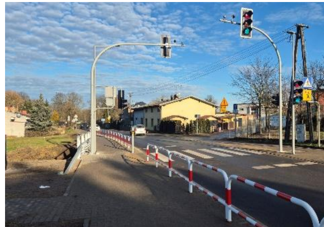
Sygnalizacja świetlna w Lusówku (fot. Zarząd Dróg Powiatowych w Poznaniu)
