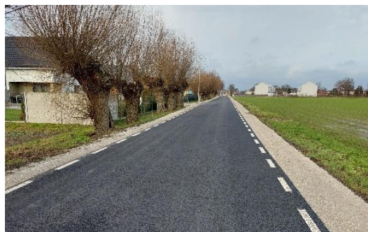
Wyremontowana droga Kleszczewo – Poklatki
