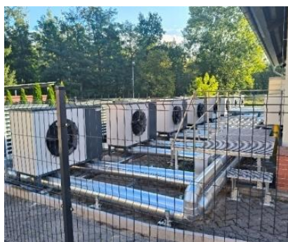
Instalacja pomp ciepła na potrzeby c.o. i c.w.u. Domu Pomocy Społecznej w Lisówkach
