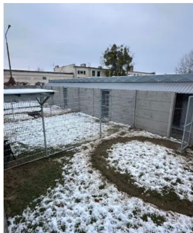
Dofinansowanie remontu zaplecza psów policyjnych przy ul. Taborowej 22 w Poznaniu
