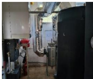
Instalacja pomp ciepła na potrzeby c.o. i c.w.u. Domu Pomocy Społecznej w Lisówkach
